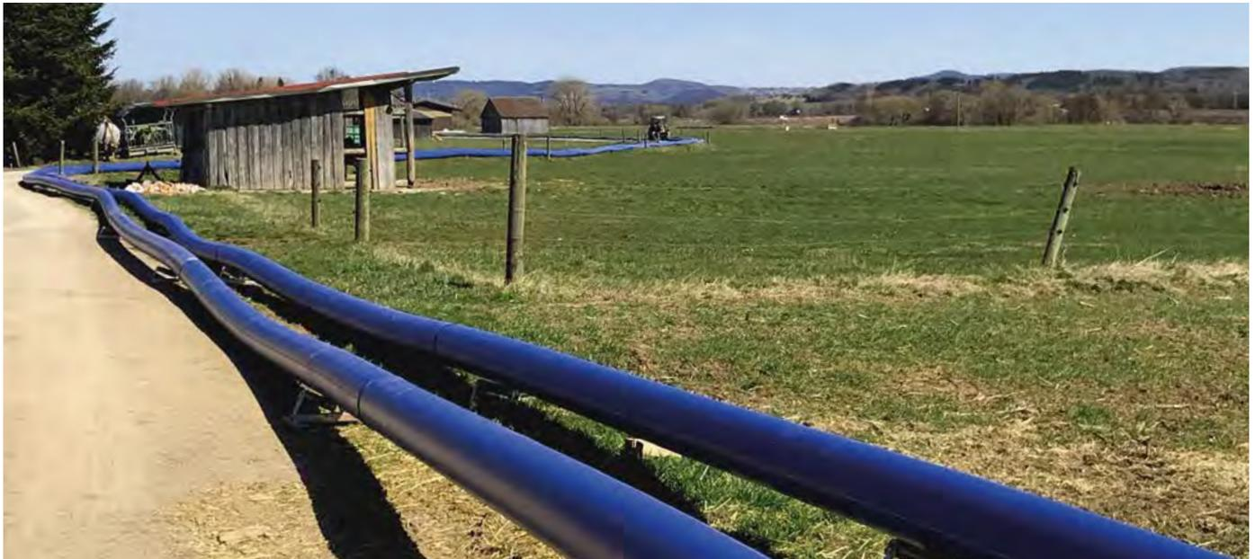
Für die Anbindung eines neuen Tiefbrunnens an das Wasserwerk entschied sich die Stadt Donaueschingen für Wavin TS<sup>DOQ</sup>® in der Nennweite DA 280. Das robuste Dreischichtrohr hält auch ohne äußere Mantelschicht außerordentlichen Belastungen stand und wurde bei dem Projekt mittels Pflugverfahren und per Horizontal Bohrspülung verlegt.
