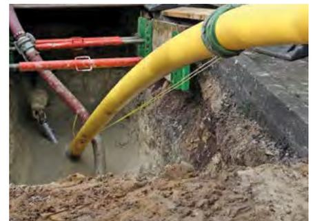
Einzug des Polyamid 12 Gasrohres im HDD-Verfahren
