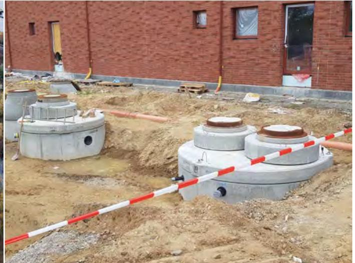
Sicherheitsauffangbecken und Leichtflüssigkeitsabscheider wurden außerhalb der Fahrzeughalle eingebaut (Foto: aib-Bauplanung Nord)
